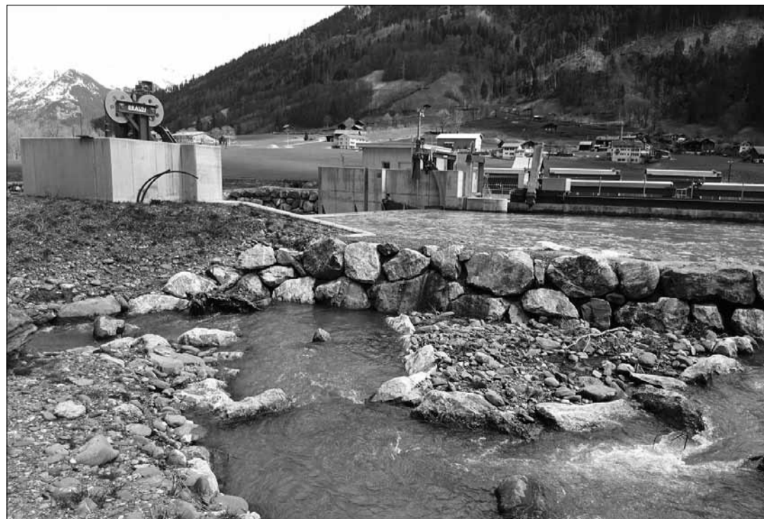
Kleinkraftwerk Rufi (Glarus). Im Vordergrund das Umgehungsgerinne des KW Rufi (GL) für den Fischauftstieg. Dahinter das Stauwehr und ganz im Hintergrund der 3-Kammer-Entsander des Ausleitkraftwerks. (Bild Swiss Small Hydro)
