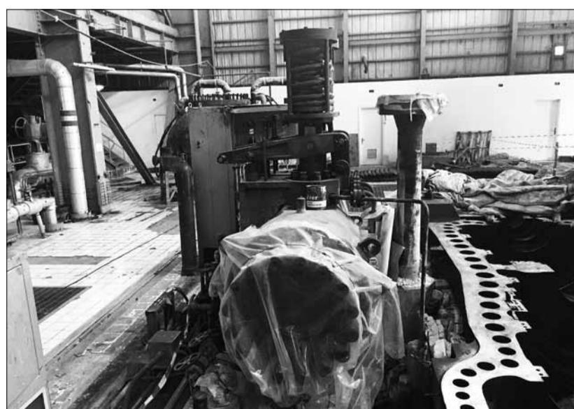
Dans la centrale électrique d'Alep, les cinq turbines ont été détruites par ISIL. Elles sont désormais réparées manuellement. La turbine 5 a pu être remise en service durant l'été 2022. (photo Karin Leukefeld)
