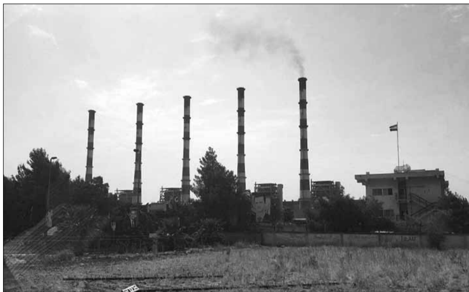
Ein Schornstein raucht wieder im Kraftwerk von Aleppo. (Bild Karin Leukefeld)
