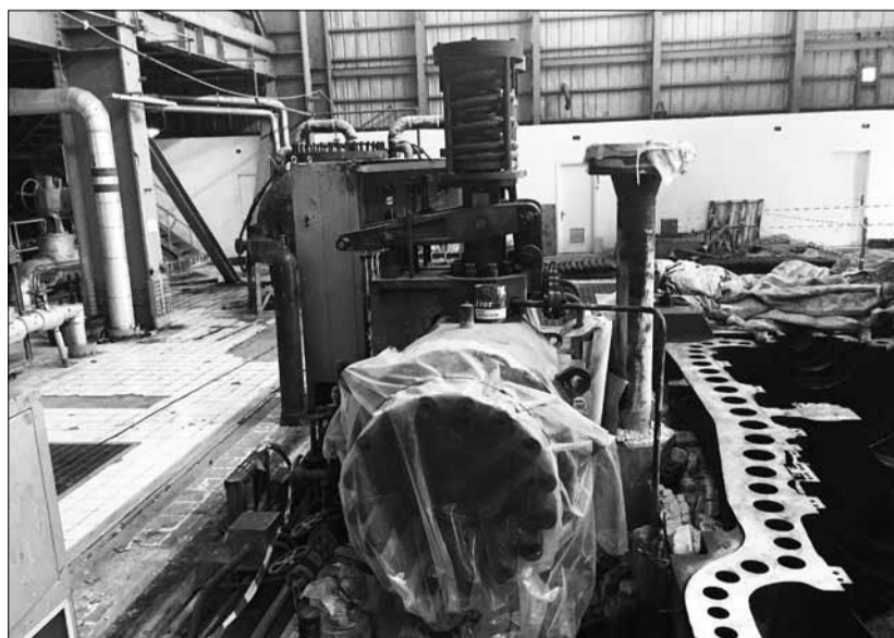
Im Kraftwerk von Aleppo wurden alle fünf Turbinen von ISIL zerstört. Nun werden sie in Handarbeit repariert. Turbine 5 konnte im Sommer 2022 wieder in Betrieb genommen werden. (Bild Karin Leukefeld)
