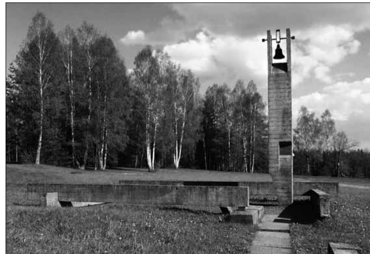
Pour chacune des maisons incendiées, il y a un obélisque en forme de cheminée, sur lequel se trouvent des plaques en bronze avec les noms de ceux qui sont nés et ont vécu ici. En haut de chaque obélisque se trouve une cloche au son triste. Les cloches sonnent simultanément toutes les 30 secondes.
