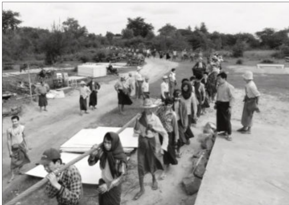
Les cordes font partie des éléments les plus importants pour la construction d'un pont. Tous sont impliqués dans le transport, action en commun accomplie avec aisance, mais exigeante; ici à Ywar Wai, Mandalay au Myanmar (photo Toni Rüttimann)
