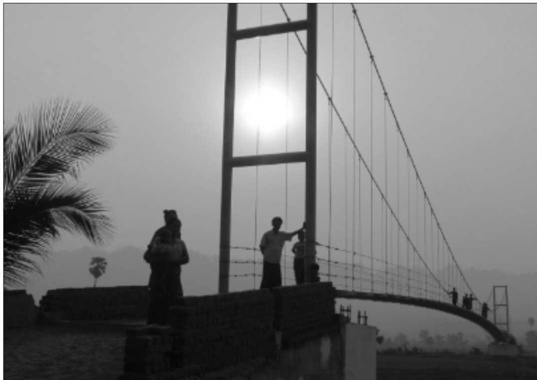
Les ponts relient les villageois, jadis isolés, entre eux. Ils sont indispensables pour faire face à la vie quotidienne. Ils permettent de s'acquérir des denrées, de bénéficier de soins médicaux adéquats. En plus, la sécurité du chemin de l'école est garantie, préalable à l'accès des enfants à l'éducation (photo Toni Rüttimann)
